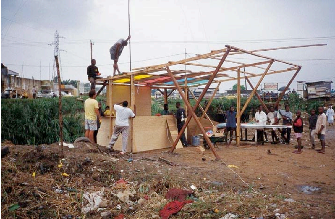
[Construcción de la emisora de la radio en Bessengue, Camerún. Nov. 2002]
